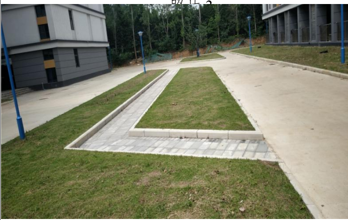
照片 3 说明：拍摄时间为 2022 年 11 月 4 日，A 区工程措施，透水铺装，3520 m 2 ，运行状态正常。
