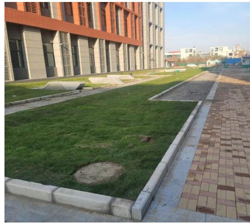
照片8说明：拍摄时间为2023年3月15日，B区植物措施，绿化区，4576.5 m 2 ，运行状态正常。
