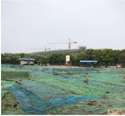
照片7说明：拍摄时间为2021年5月15日，B区临时措施，临时苫盖，面积约4000 m 2 。
