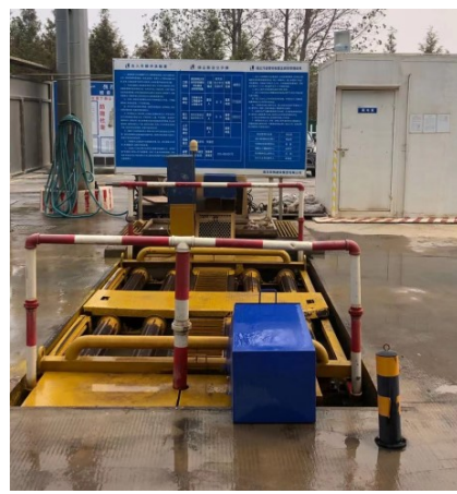
照片 6 说明：拍摄时间为 2021 年 4 月 27 日，B 区临时措施，洗车平台 1 套、沉淀池 1 座，运行状态正常。
