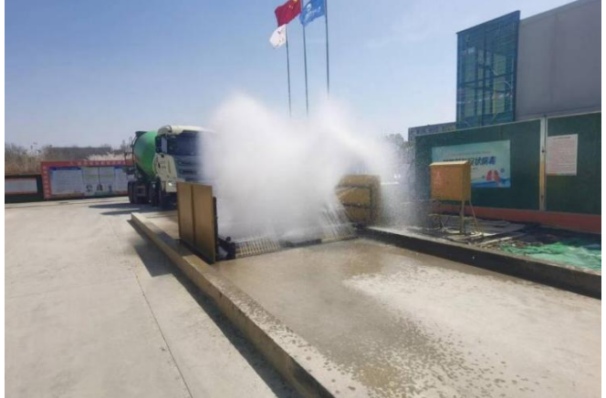
照片 4 说明：拍摄时间为 2021 年 5 月 11 日，A 区临时措施，洗车平台 1 套，运行状态正常。
