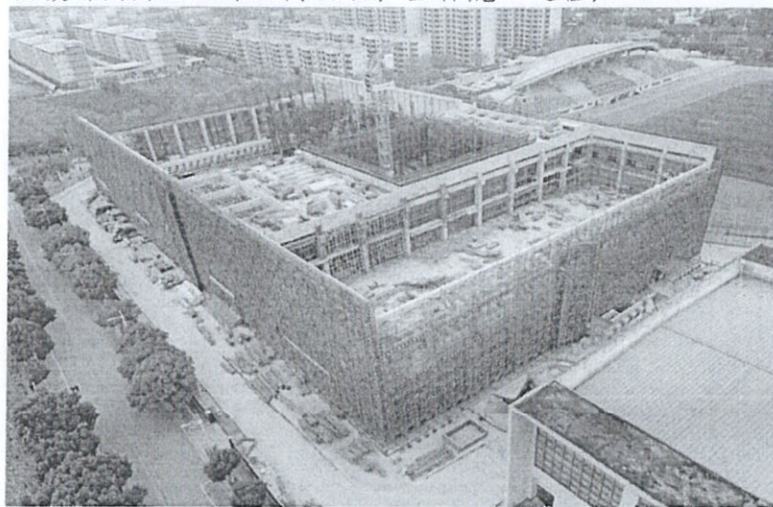
拍摄时间为2022年12月13日，主体施工过程中
